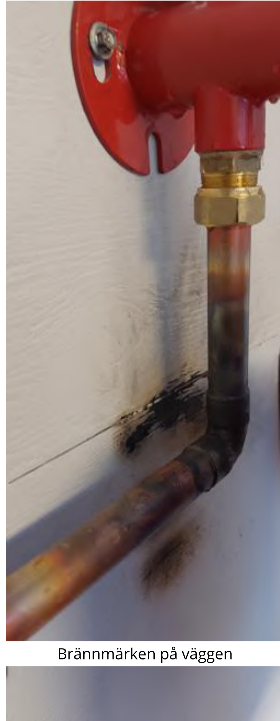
Utblåsningsledning saknas
