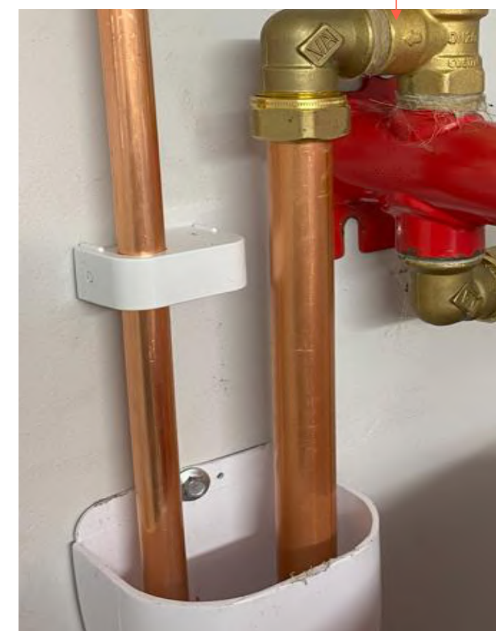
Klammer på utblåsningsledning saknas
